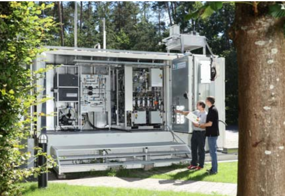
Aufbau eines innovativen Wasserstoffspeichers am Leistungszentrum Elektroniksysteme Nürnberg-Fürth-Erlangen des Fraunhofer-Instituts für Integrierte Systeme und Bauelemente-technologie IISB
